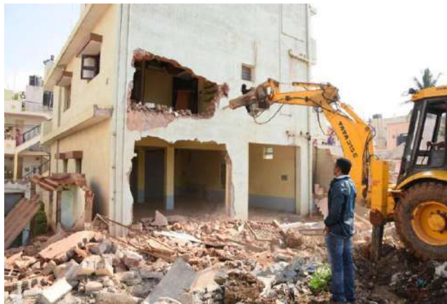
شکل ۳-۱ تخریب ساختمان با پیکور
