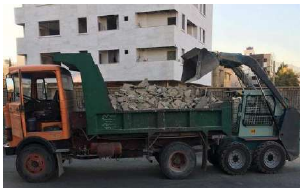
شکل ۱-۱۰ بارگیری و حمل نخاله‌ها به بیرون کارگاه
