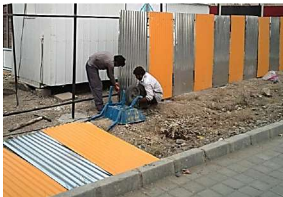
شکل ۱-۶ محصور کردن محوطه کارگاه قبل از تخریب
