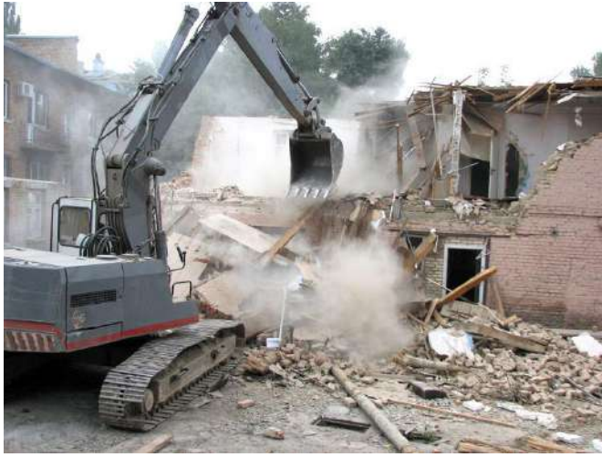
شکل ۲-۱ تخریب مکانیکی توسط بیل مکانیکی
