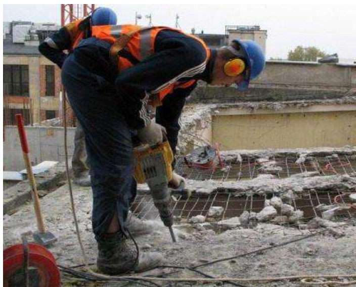
شکل ۷-۱ تخریب دستی سقفها از بالاترین نقطه ساختمان
