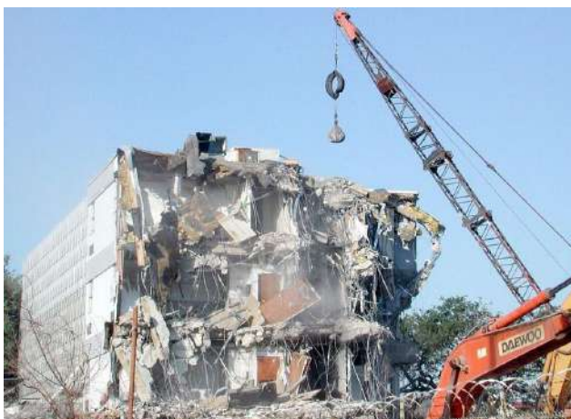
شکل ۱-۵ تخریب با استفاده از ضربه گوی فلزی
