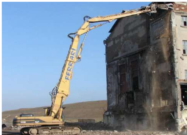
شکل ۴-۱ تخریب با فیچی هیدرولیک
