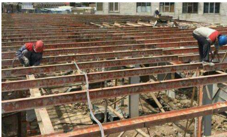
شکل ۹-۱ برش آهن آلات اسکلت با هوا برش
